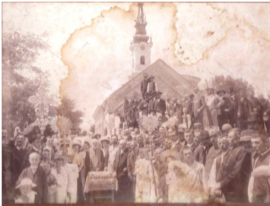
Fig. 1. Punerea pietrei de temelie la școala centrală și la sala de joc
